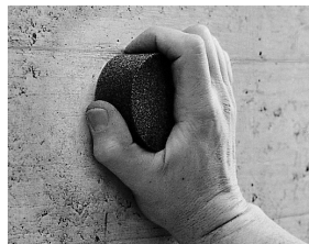
Fig. 2.1 Préparer la surface à examiner
